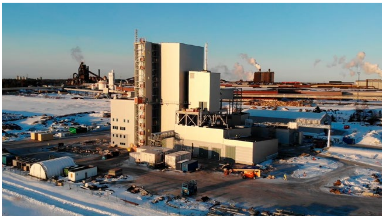
Завод по производству «зеленой» стали в Лулео, Швеция
