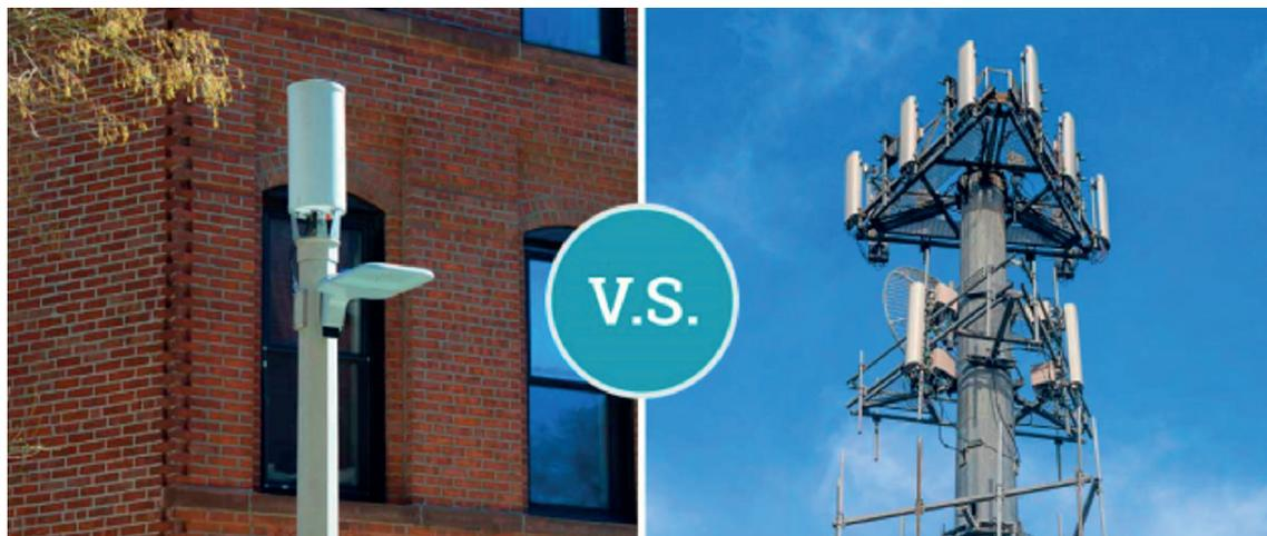
Рисунок 5 – Решение small cells (слева), по сравнению с обычной базовой станцией Macro BTS в сети предыдущих поколений
