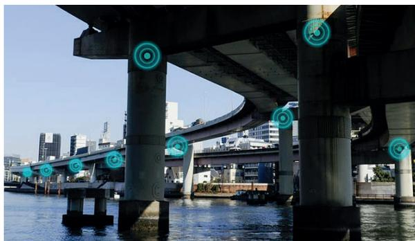
Рисунок 31 — Пример размещения датчиков вибрации на основе NB-IoT для контроля целостности моста компании Arbor Technology
