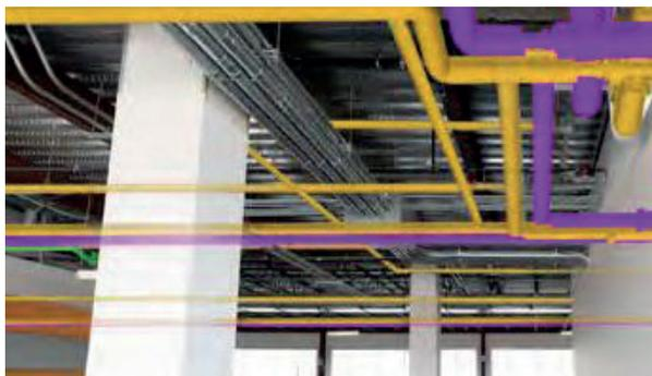
Рисунок 23 – Проекция на AR-гарнитуру будущего размещения труб в подпотолочном пространстве с использованием решения компании Trimble
